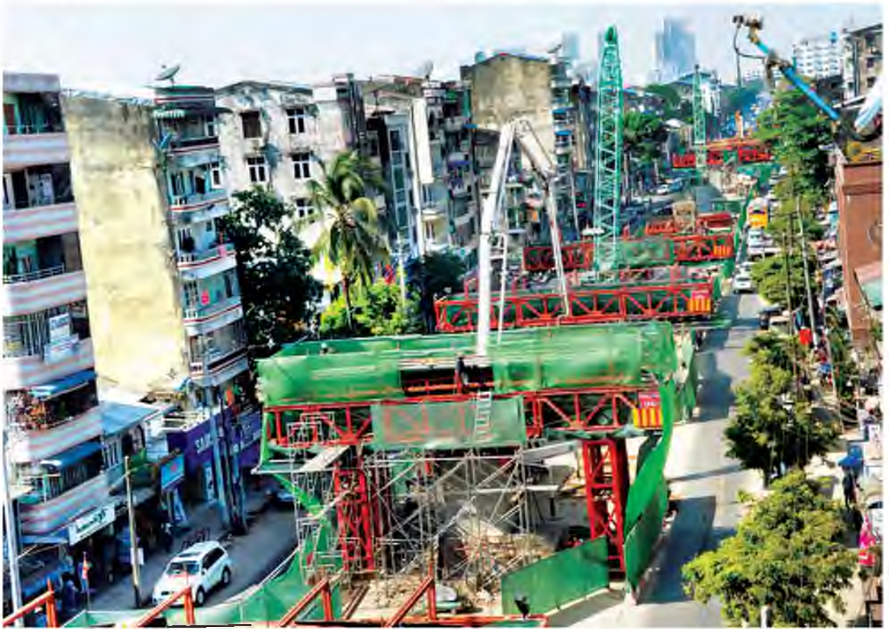
ဆောက်လုပ်ဆဲ တာမွေလမ်းဆုံ ဝိုင်ပုံသဏ္ဌာန် ခုံးကျော်တံတားလုပ်ငန်းခွင်ကို တွေ့ရအောင်။
