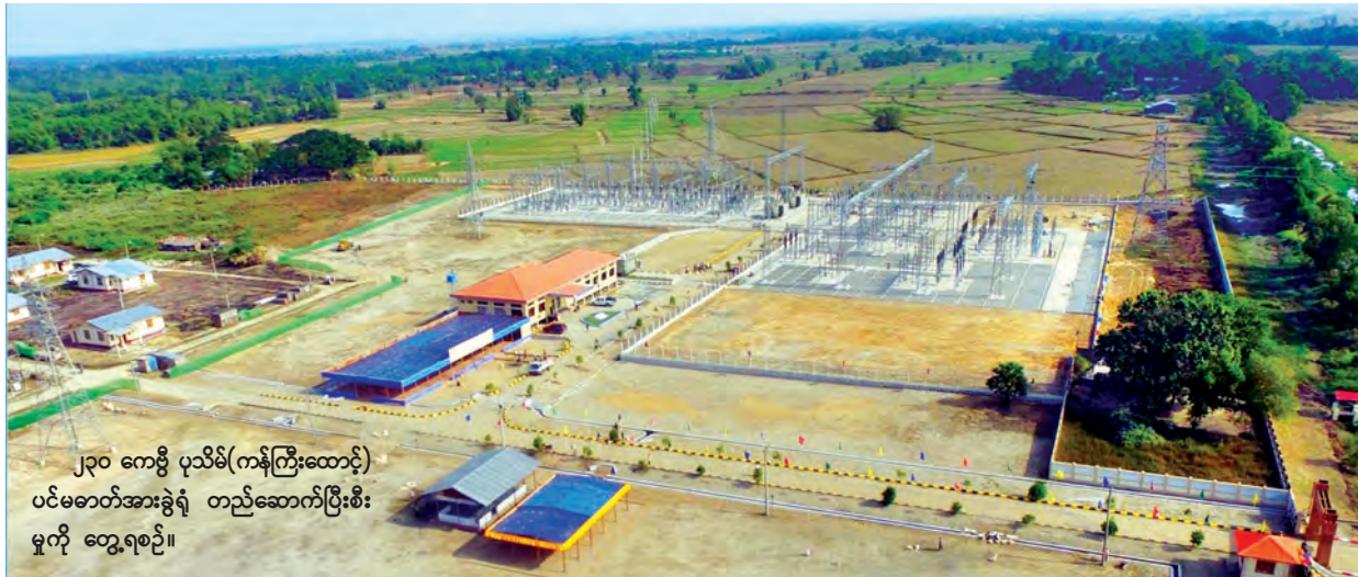
၂၃၀ ကေစီ ပုသိမ်(ကန်ကြီးထောင့်) ပင်မဓာတ်အားခွဲရုံ တည်ဆောက်ပြီးစီး မှုကို တွေ့ရစဉ်။
