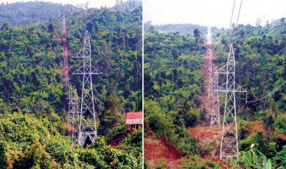
၆၆ ကေစီ ပုသိမ်-ငရုတ်ကောင်း-ငပြေမဓာတ်အားလိုင်း Lattice Tower တိုင်ဆင်ခြင်းနှင့် ကြိုးဆွဲခြင်း လုပ်ငန်းများ ဆောင်ရွက်ထားမှုကို တွေ့ရစဉ်။
