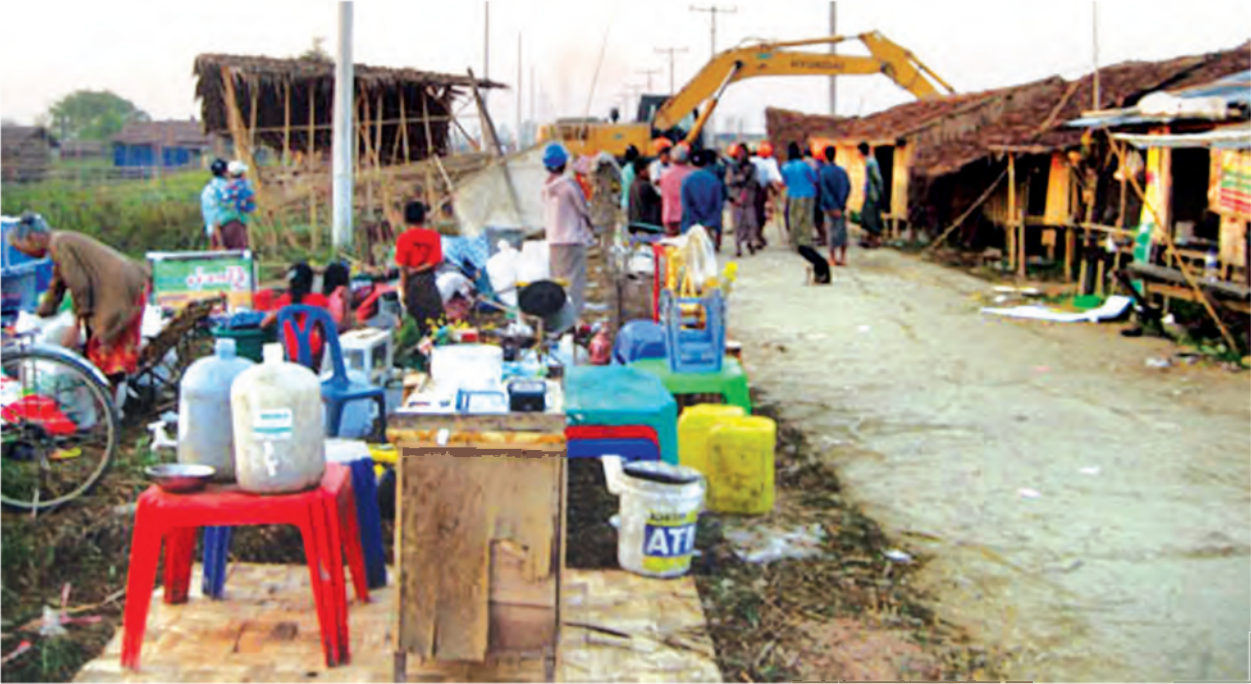
ကျွန်းကျော်တံများကို စက်ယန္တရား များဖြင့်ရှင်းလင်း ဖယ်ရှားစဉ်။
