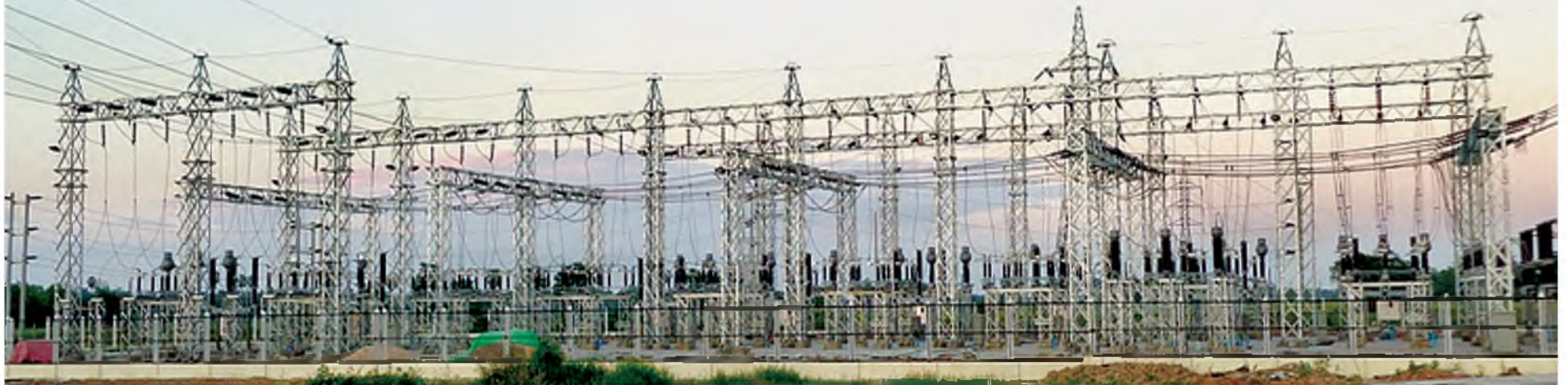
၂၃၀ ကေဇီ ပုသိမ်ဓာတ်အားစွဲရုံ တည်ဆောက်ပြီးစီးမှုကို တွေ့ရစဉ်။
