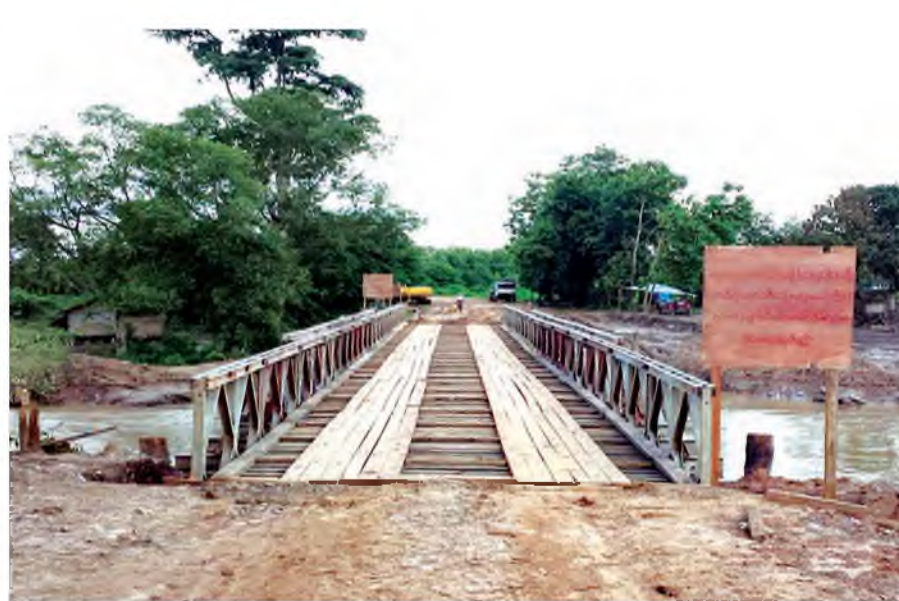
မန္တလေး-တကောင်း- ဗန်းမော်လမ်းပေါ်ရှိ ဟင်္သာချောင်းတံတား (၃/၇၈) ပေ (၀၄၀) ဘေလီတံတား ပြုပြင်ဆောင်ရွက်ပြီး တွေ့ရစဉ်။ (ဆောက်လုပ်ရေး)
