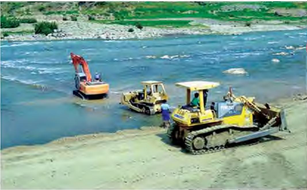
သောင်နံ (၂) တူးဖော်ခြင်းလုပ်ငန်းတွင် Cause Way ဆောင်ရွက်နေမှုကို တွေ့ရစဉ်။
