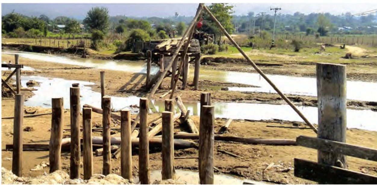
အသစ်ပြန်လည်ဆောက်လုပ်နေသော ကျေးရွာချင်းဆက်တံတားကို တွေ့ရစဉ်။
