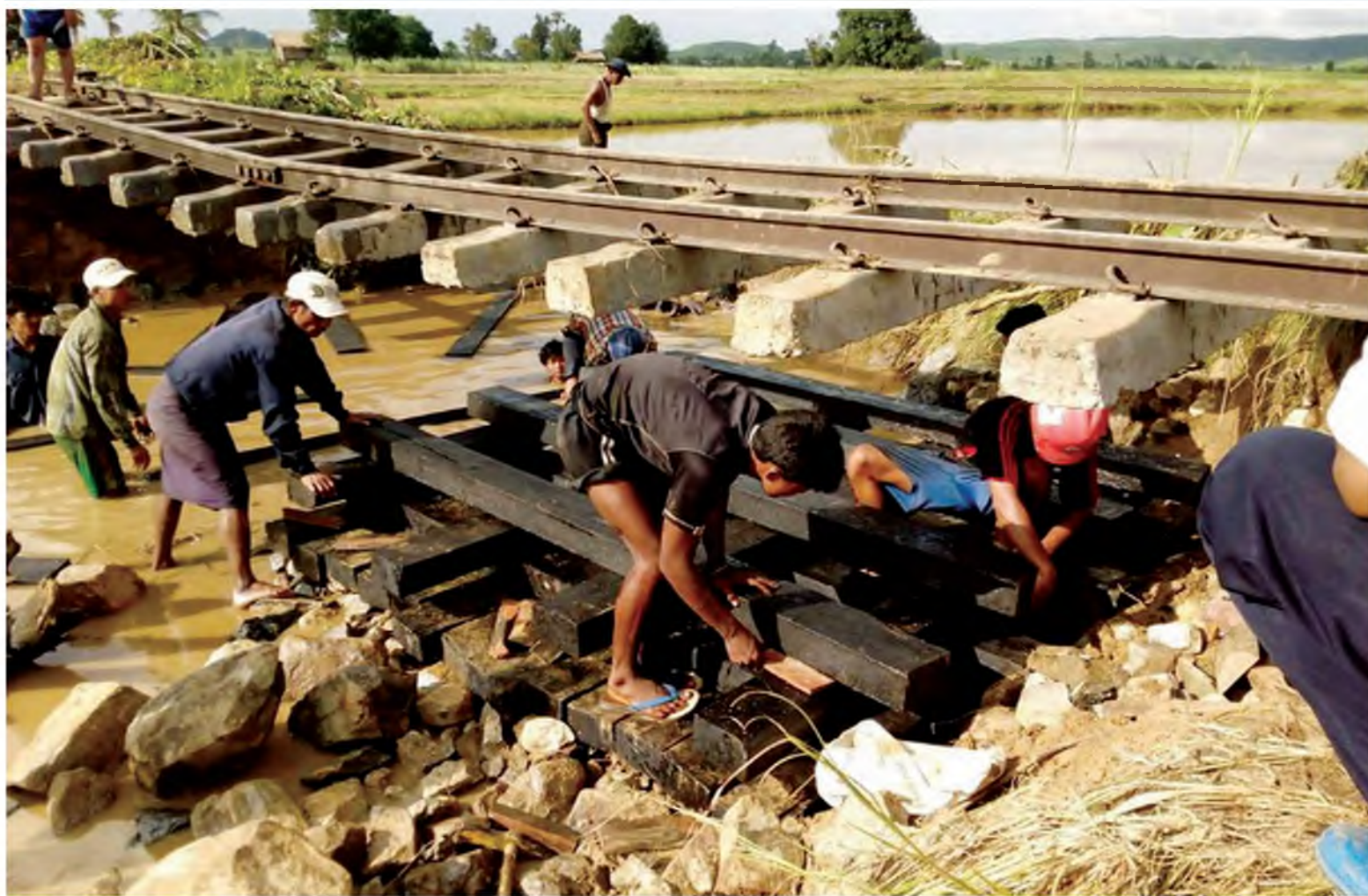
စစ်ကိုင်းတိုင်းဒေသကြီးအတွင်း ရေကြီးမှုကြောင့် ပျက်စီးခဲ့သည့် ရထားလမ်းပိုင်းများ စုစုပေါင်း ၂၂ ရက်က ပြန်လည်ပြုပြင်နေသည်ကို တွေ့ရစဉ်။ (သတင်း၊ စာမျက်နှာ-၅) (မာတိပုံ-MRT)
