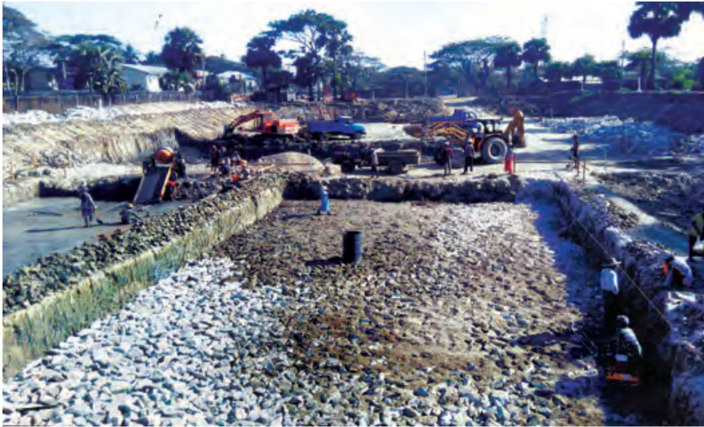
ဖျာပုံမြို့ရှိ ရေစုကန်၊ ရေစစ်ကန်များ တည်ဆောက်နေမှုကို တွေ့ရစဉ်။
