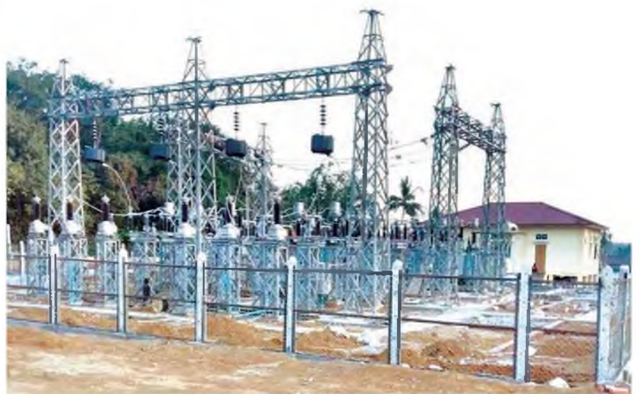
၆၆/၁၁ ကေစီ၊ ၃၀ အမ်ပီအေ ချောင်းဆုံ ဓာတ်အားခွဲခွဲ တည်ဆောက်ရေးလုပ်ငန်း ဆောင်ရွက်နေပုံ။ (ဓာတ်ပုံ-လျှပ်စစ်)
