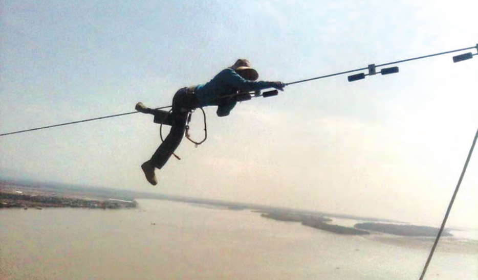
မြစ်ဖြတ်ကျော်တာဝါတိုင် ဓာတ်အားလိုင်းဆွဲခြင်းလုပ်ငန်းကို လျှပ်စစ်ဝန်ထမ်းများ သက်စွန့်ဆံဖျား ဆောင်ရွက်နေစဉ်။
