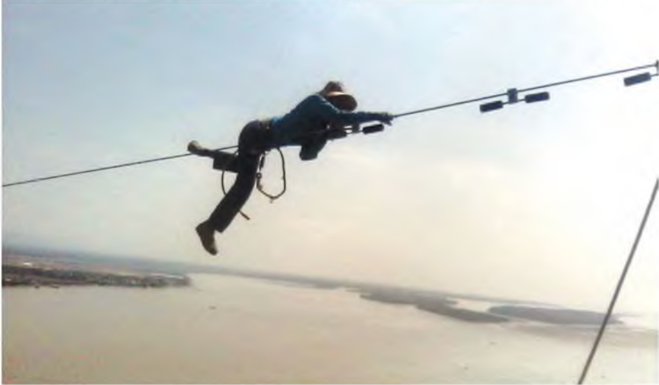
မြစ်ဖြတ်ကျော်တာဝါတိုင် ဓာတ်အားလိုင်းဆွဲခြင်းလုပ်ငန်းကို လျှပ်စစ်ဝန်ထမ်းများ သက်စွန့်ဆဲဖျား ခောက်ပုံ-လျှပ်စစ်ဆောင်ရွက်နေစဉ်။
