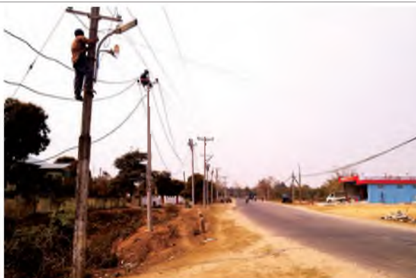
ကချင်ပြည်နယ် စန်းမော်မြို့နယ် လျှပ်စစ်အင်ဂျင်နီယာနှင့်အဖွဲ့သည် ပြည်သူများမှ လျှပ်စစ်ဓာတ်အားအပြည့်အဝအသုံးချနိုင်ရေး၊ လျှပ်စစ်အန္တရာယ် ကင်းရှင်းစေရေးအတွက် အောင်သာရပ်ကွက်၊ စန်းမော်-မိုးမောက်ကားလမ်း တွင် လက်ရှိ ၁၀ မီတာရှိ ကွန်ကရစ်တိုင်များ၌ စိုက်ထူခြင်းနှင့် ကြံ့ခိုင်မှု အားနည်းသော လက်ရှိလျှပ်စစ်မီးကြိုးများ အစားထိုးတပ်ဆင်ခြင်းကို မတ် ၁၇ ရက်က ဆောင်ရွက်နေစဉ်။ ဆီမီးခုံ- နန်းရီ
