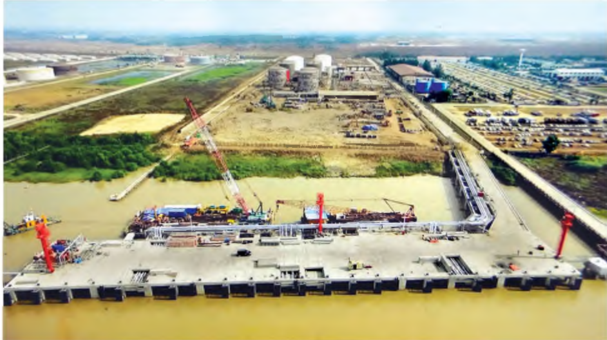
ရန်ကုန်မြို့၊ သီလဝါဆိပ်ကမ်း၊ ကတ္တရာနှင့် ရေနံဆက်စပ်ပစ္စည်းများ တင်/ချ ဆိပ်ခံတံတားနှင့် သိုလှောင်ကန်များ တည်ဆောက်ပြီးစီးမှုကို တွေ့ရစဉ်။
