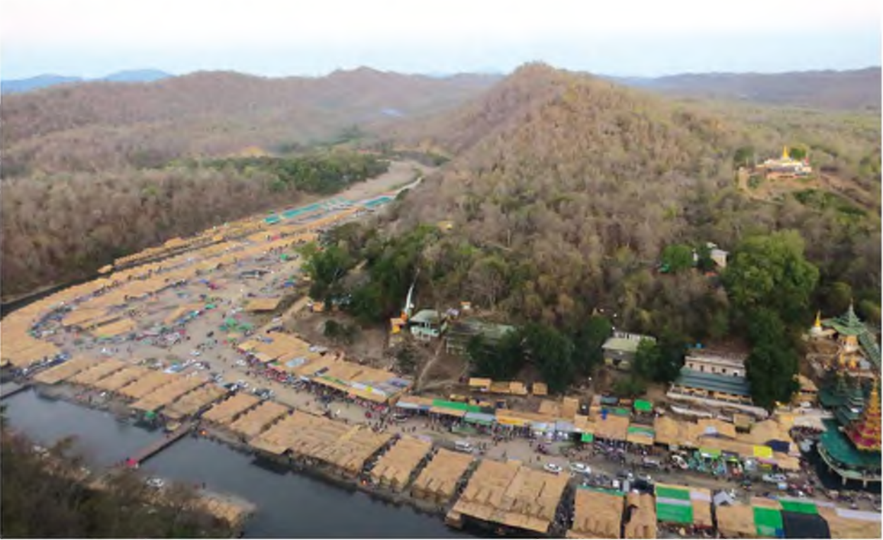
ဘုရားပွဲကာလအတွက် ကြိုတင်ဆောက်လုပ်နေပြီဖြစ်သော တည်းခိုဆောင်နှင့် ဈေးဆိုင်ခန်းများ။
