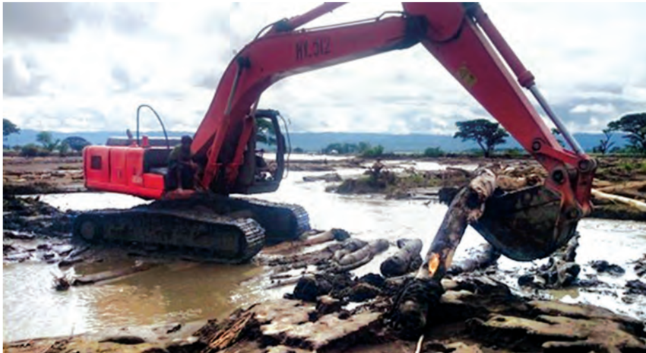
ရေကြီးဒေသများတွင် ပြန်လည်ထူထောင်ရေးလုပ်ငန်းများ ဆောင်ရွက်လျက်ရှိရာ ဩဂုတ် ၁၇ ရက်က ဇင်းကလင်း-ပေါက်ခုံ-ရေလှည့်ဦးကျေးရွာချင်းဆက်လမ်းကို စက်ယန္တရားများဖြင့် ပြန်လည်ဖြုတ်ဖောက်လုပ်နေသည်ကို တွေ့ရစဉ်။ (ဓာတ်ပုံ-ဆည်မြောင်း)
