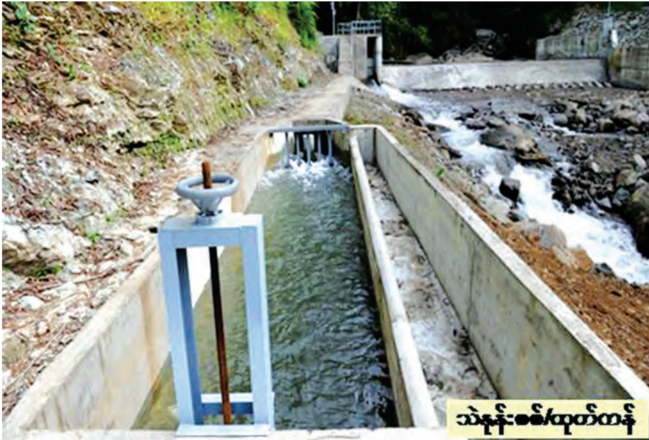
လဟယ်မြို့နယ် ကျလွေချောင်း ရေအားလျှပ်စစ်စီမံကိန်း ဆောင်ရွက်ပြီးစီးမှုအခြေအနေကို တွေ့ရစဉ်။
