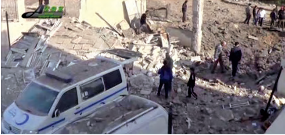
အလက်ပိုဗ် ခုံးကျည်တိုက်ခိုက်မှုများကြောင့် ပျက်စီးခဲ့သည့် ဆေးရုံအဆောက်အအုံနေရာအနီးတွင် လူအချို့ကိုတွေ့ရစဉ်။
