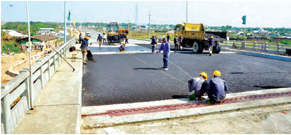
ရွှေပေါက်ကံတံတား (လေးလမ်းသွား) ပင်မတံတား ကတ္တရာခင်းခြင်းလုပ်ငန်းဆောင်ရွက်နေမှုကို တွေ့ရစဉ်။
