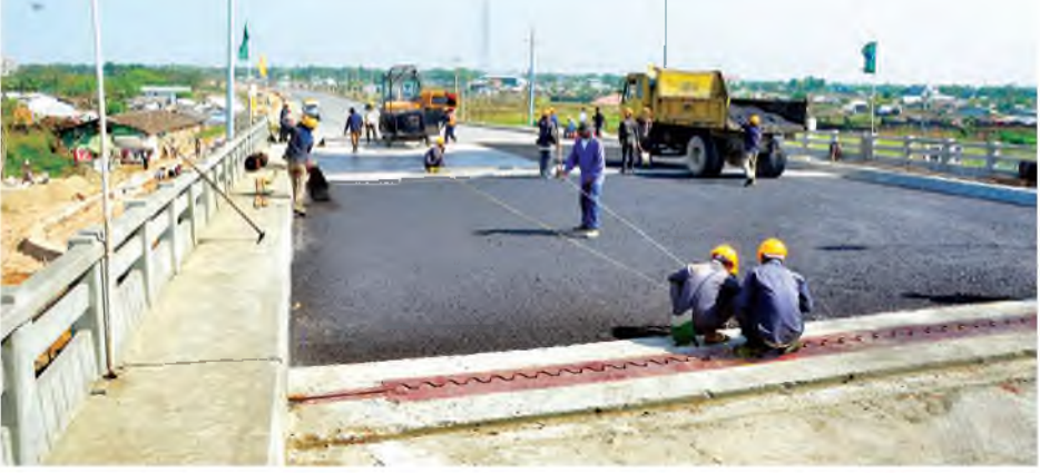
ရွှေပေါက်ကံတံတား (လေးလမ်းသွား) ပင်မတံတား ကတ္တရာခင်းခြင်းလုပ်ငန်းဆောင်ရွက်နေမှုကို တွေ့ရစဉ်။
