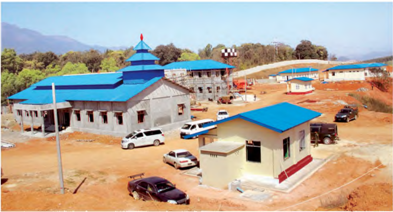
လောက်ကိုင်မြို့ရှိ ရှမ်းမြေဂုဏ်ဝေသီလရှင်ကျောင်း တည်ဆောက်မှုလုပ်ငန်းခွင်အား တွေ့ရစဉ်။ (သတင်းစဉ်)
