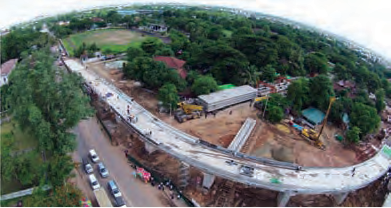
အင်းစိန်ရထားလမ်း ခုံးကျော်တံတားအသစ် တည်ဆောက်ရေး စီမံကိန်းကို တွေ့ရစဉ်။
