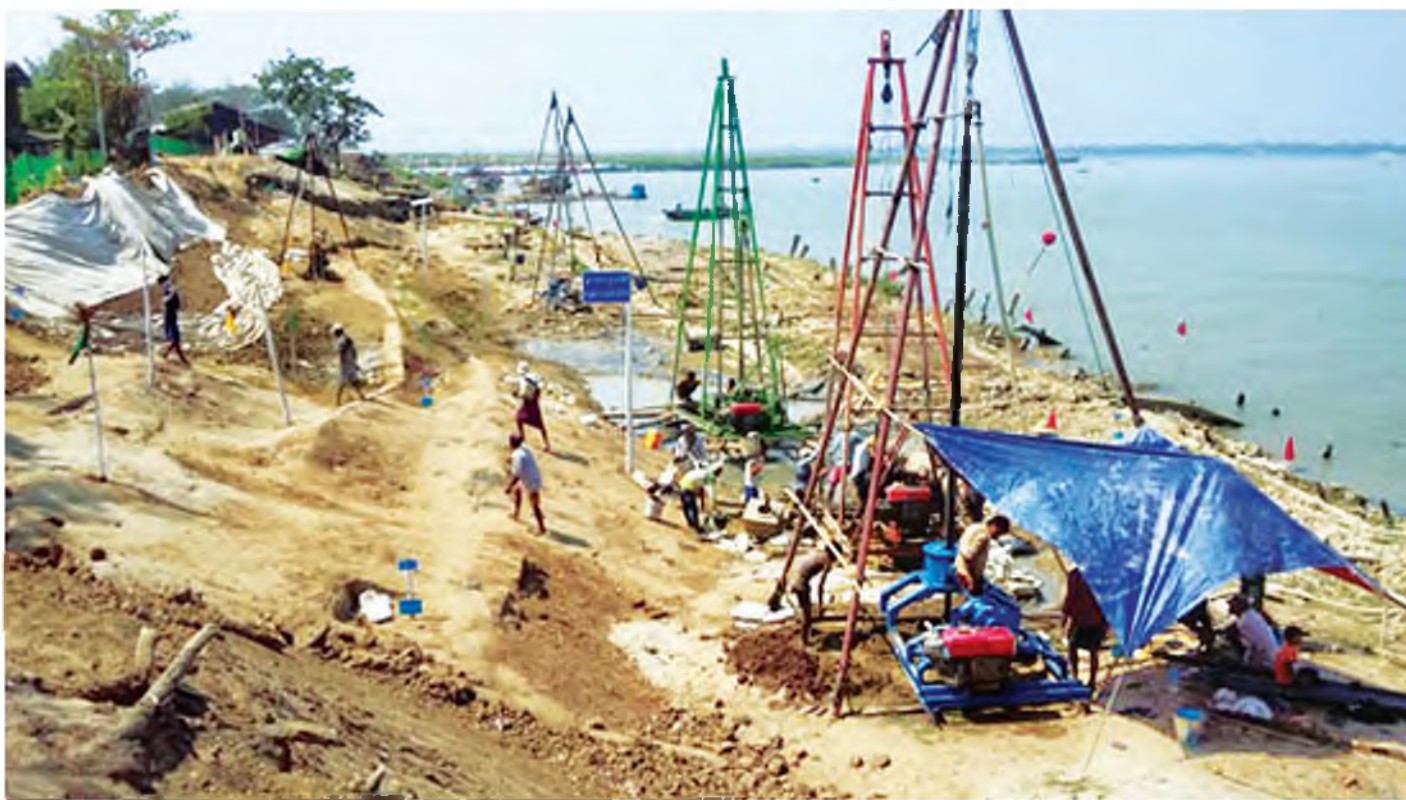
ဧရာဝတီတိုင်းဒေသကြီး၊ ညောင်တုန်းတာတမံ တည်ဆောက်နေမှုအခြေအနေကို တွေ့ရစဉ်။
