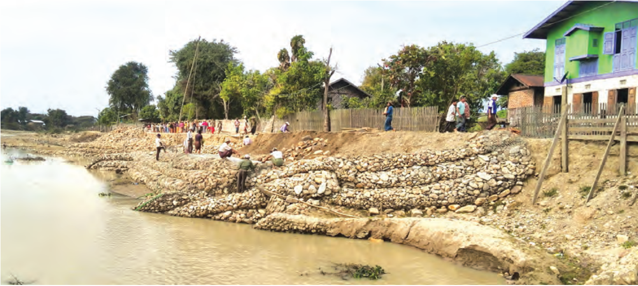
ခန့်အကွန်ကျခံတည်ဆောက်နေခြင်းဖြစ်ကြောင်း သိရသည်။ ယင်းကျောက်စီရေထိန်းနံရံပြီးစီးသွားပါက ရေဘေးဒဏ်ကြောင့် ကမ်းပြိုမှုကို ကြိုတွေ့နေရသည့် ကချင်ပြည်နယ်ပင်လုံကျေးရွာအုပ်စု
