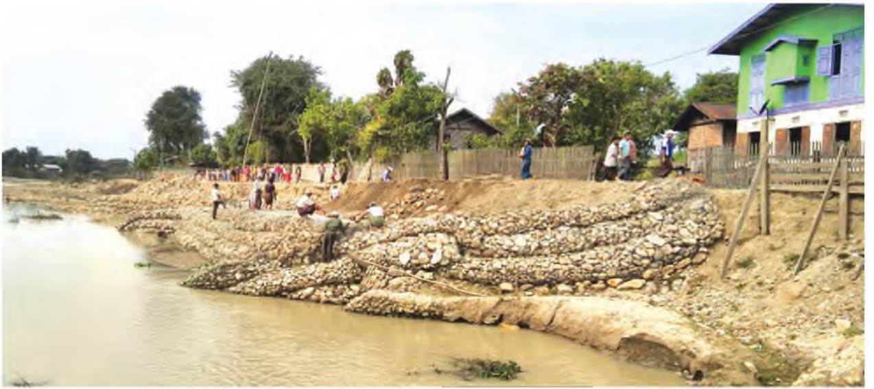
ခန့်အကွန်ကျခံတည်ဆောက်နေခြင်းဖြစ်ကြောင်း သိရသည်။
