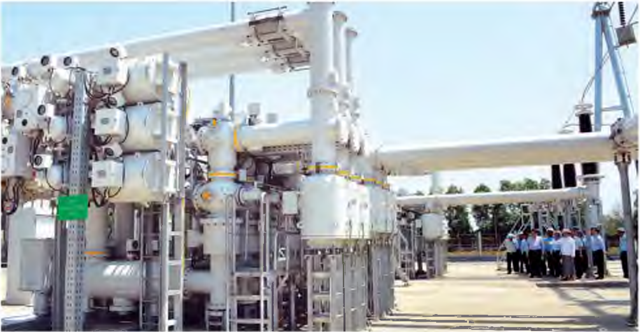
ယခု ထည်ဆောက်လျက်ရှိသော 230/66/11 KV (2x125) MVA (GIS) ဓာတ်အားခွဲရုံသည် မြန်မာနိုင်ငံ၌ ပထမဦးဆုံးတည်ဆောက်သော ခေတ်မီဓာတ်အားခွဲရုံတစ်ခုဖြစ်ပြီး အဆိုပါဓာတ်အားခွဲရုံ တည်ဆောက် ပြီးစီးပါက ရန်ကုန်တိုင်းဒေသကြီးအတွင်းရှိ ဒဂုံမြို့သစ်(အရှေ့ပိုင်း)မြို့နယ်၊
