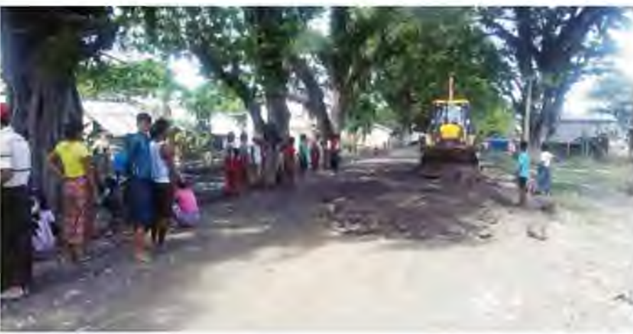
ကလေး-ပြင်သာ ကွန်ကရစ်လမ်းမခင်းကျင်းရန် ၀၈-၉-၂၀၁၅ ရက်က ဆောင်ရွက်နေစဉ်။ (သတင်းစဉ်)
