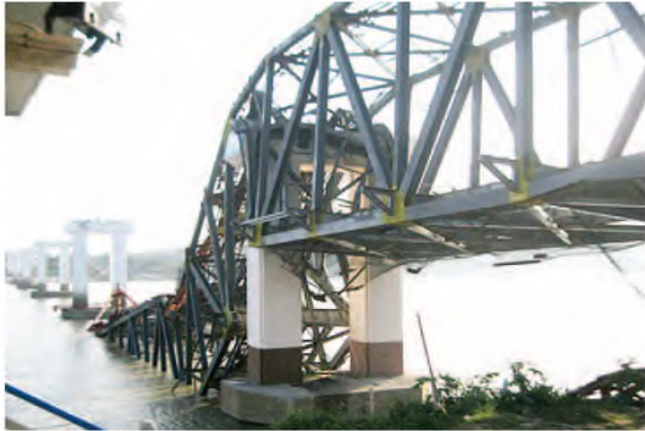
၂၀၁၂ ခုနှစ်တွင် သပိတ်ကျင်းမြို့၌ ရန်ချီတာစကေး ၆ ဒသမ ၈ ငလျင်ကြီးလှုပ်ခတ်မှုကြောင့် ရောဂတ်မြစ်ကူး ရတနာသိယံတံတားပြိုကျပျက်စီးမှုအား တွေ့ရစဉ်။
