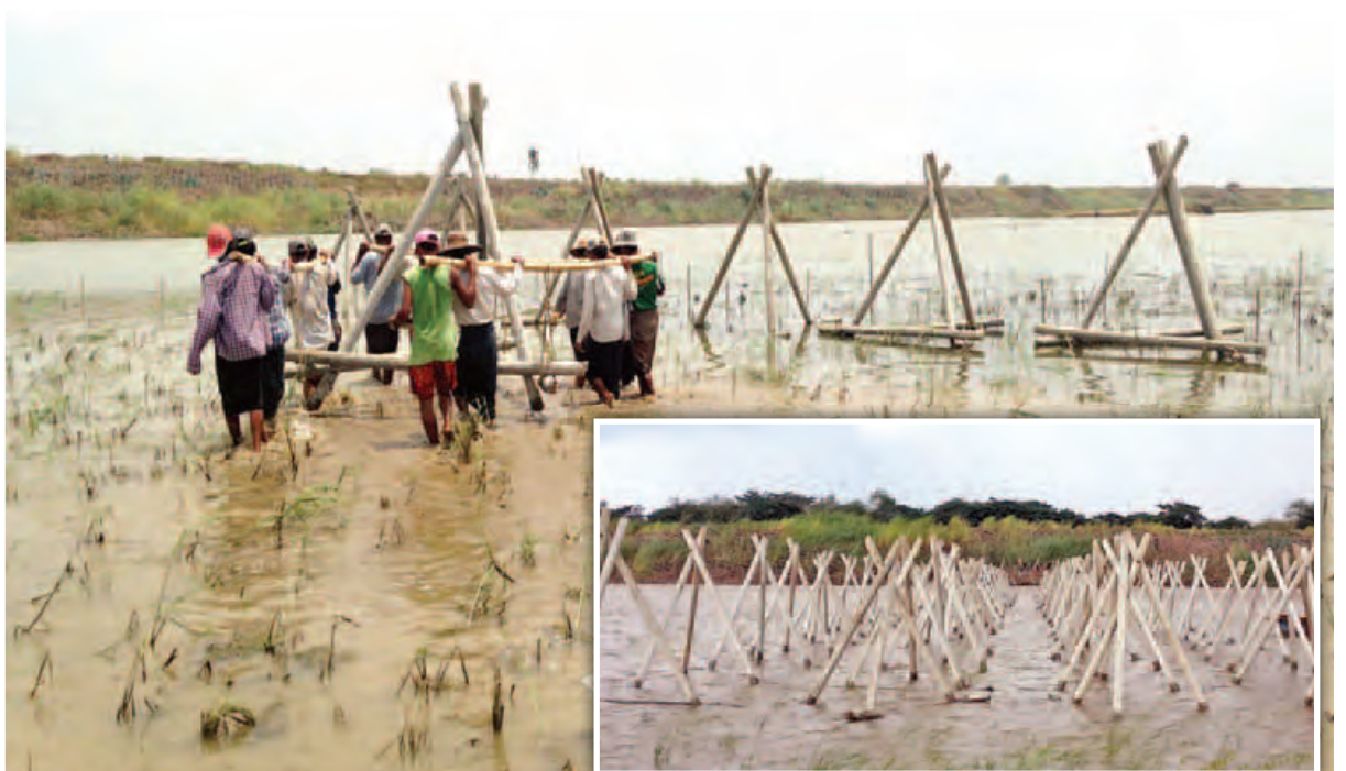
ရောဝတီမြစ်ရေတိုက်စားမှုကြောင့် မြစ်ကမ်းပြိုမှုများမှ ကာကွယ်နိုင်ရန် ကွန်ကရစ်တိုင်များဖြင့် မြစ်ကမ်းထိန်းသိမ်းကာကွယ်မှုကို တွေ့ရစဉ်။
