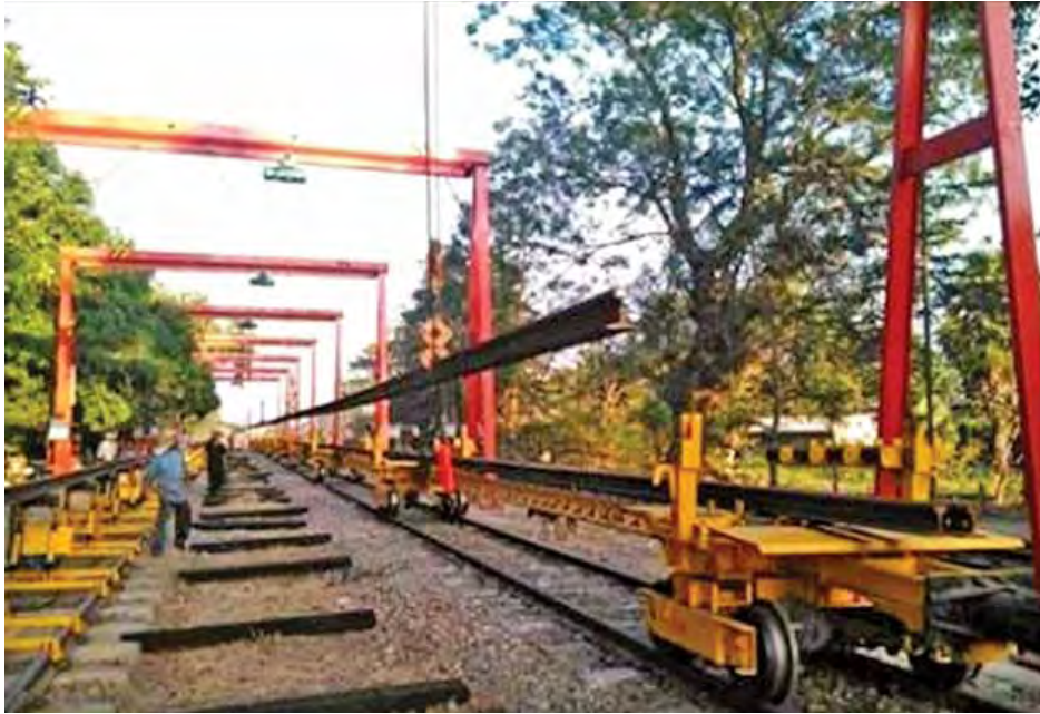
ဝေါဘူတာတွင် Gantry Crane ဖြင့် ၉ ချောင်းဆက်ပြီးသော သံလမ်းများကို လမ်းပိုင်းသို့ ပို့ရန်ဆောင်ရွက်နေစဉ်။
