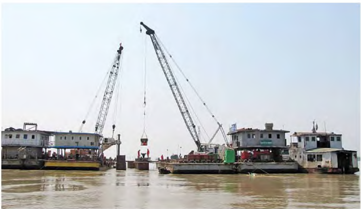
သံလွင်တံတား(ချောင်းဆုံ)ရေလယ်တိုင် တည်ဆောက်ရေးလုပ်ငန်းများ ဆောင်ရွက်နေစဉ်။
