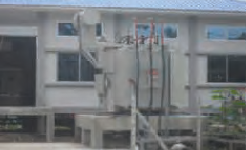
သာကေတမြို့နယ်မှ ဆောက်လုပ်ဆဲဓာတ်အားခွဲရုံတစ်ရုံကို တွေ့ရစဉ်။
