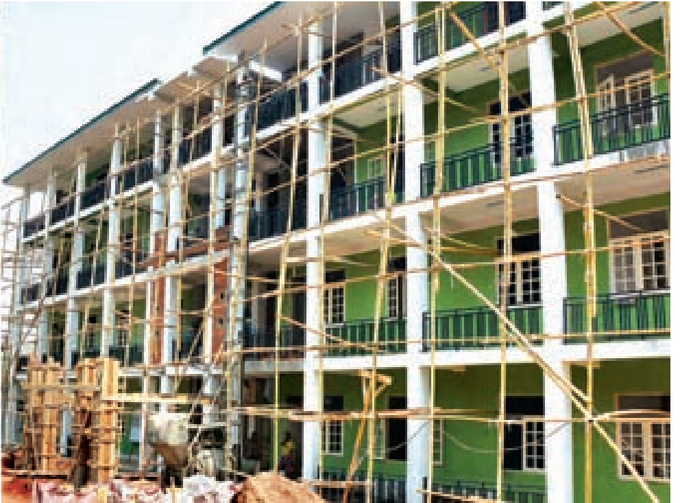
ဒုတိယသမ္မတ ဒေါက်တာစိုင်းမောက်ခမ်း လေးခန်းတွဲ လေးထပ်ဝန်ထမ်းအိမ်ရာ အဆောက်အအုံသစ် တည်ဆောက်နေမှုကို ကြည့်ရှုစစ်ဆေးစဉ်။
