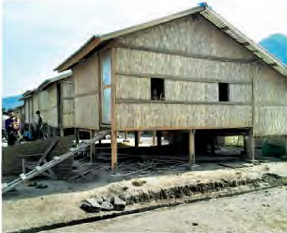
ဝေါက်တောမြို့နယ် ကြိမ်နီမြစ်စခန်း (ကံပြင်ကျေးရွာ)တွင် လုံးချင်းအိမ်ရာများ တည်ဆောက်ပြီးစီးမှုကို တွေ့ရစဉ်။
