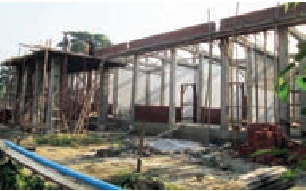
မော်လမြိုင်ကျွန်းမြို့ အောင်ဇေယျလမ်းမကြီးရှေ့ အဖြူရောင် နှလုံးသား အခမဲ့အထွေထွေရောဂါကုဆေးခန်းရှေ့တွင် ၁၆ ခုတင်ဆုံမြို့နယ် တိုင်းလင်းဆေးရုံကို ဇန်နဝါရီ ၃ ရက်မှစတင်ပြီး ဒီပဲယိဒီဆောက်လုပ်ရေး ကုမ္ပဏီက တာဝန်ယူဆောက်လုပ်လျက်ရှိရာ မတ် ၁၈ ရက်အထိ ၈၅ ရာခိုင်နှုန်း ဆောက်လုပ်ပြီးစီးနေပြီဖြစ်သည်ကို တွေ့ရစဉ်။
