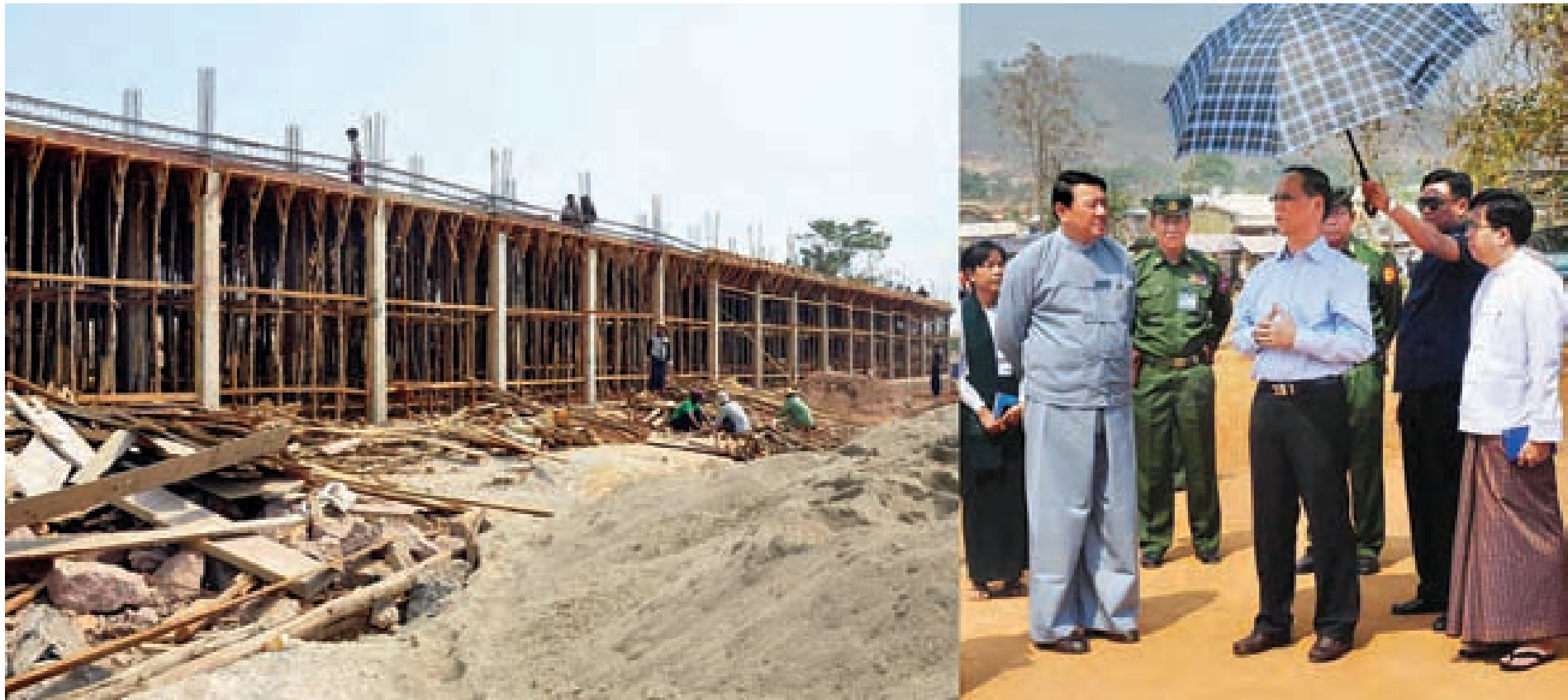
ဒုတိယသမ္မတဒေါက်တာစိုင်းမောက်ခမ်း လေ့ကျင့်ရေးအလယ်တန်းကျောင်းဝင်းအတွင်း နှစ်ထပ်စာသင်ဆောင် တည်ဆောက်နေမှုကို ကြည့်ရှုစစ်ဆေးစဉ်။
