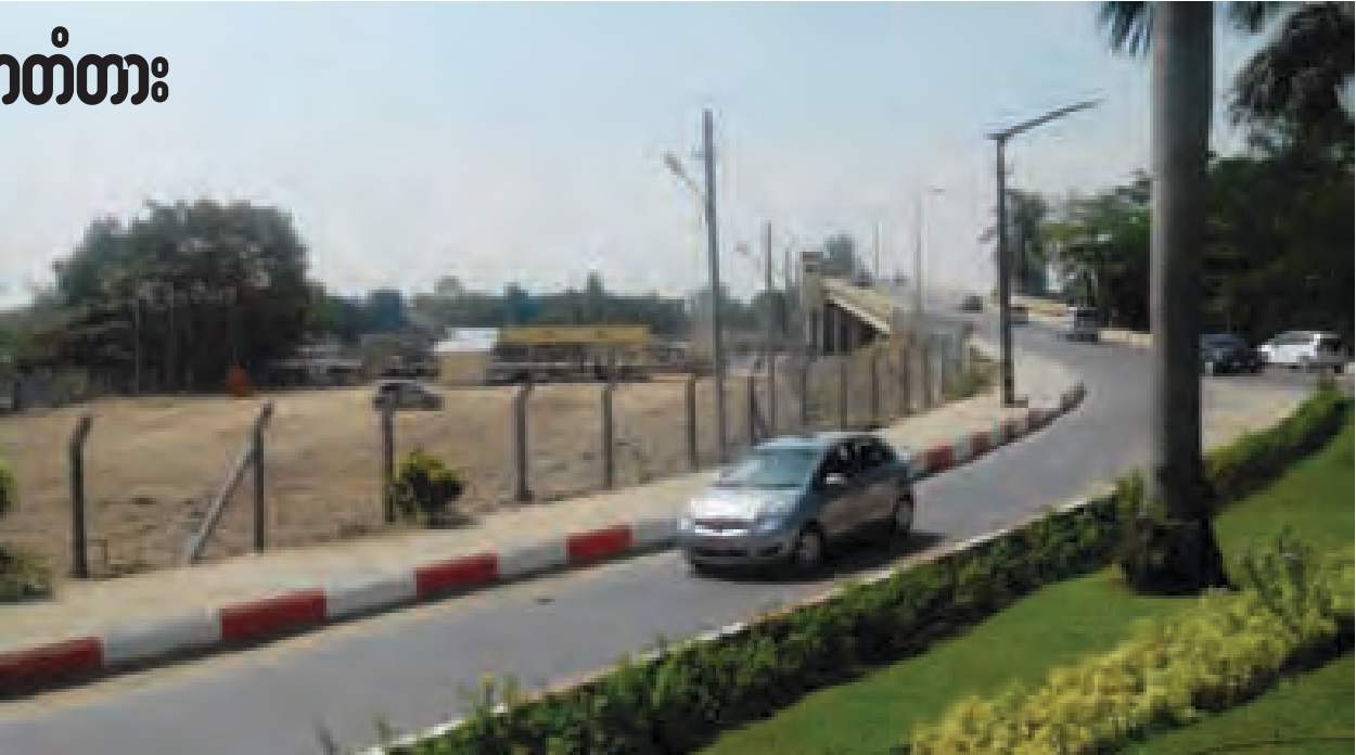
ဆောက်မည်ဖြစ်ပြီး တံတားအထူးအဖွဲ့(၁)က တာဝန်ယူထားကြောင်း သိရသည်။ တံတားသစ်ကို တည်ဆောက်ပေးလိုက်ခြင်းဖြင့် လက်ရှိတံတားဟောင်းမှ ယာဉ်သွားလာမှု၊ ယာဉ်ကြောကျပ်တည်းမှုတို့ကို လျော့နည်းသွားစေနိုင်မည် ဖြစ်သည်။
