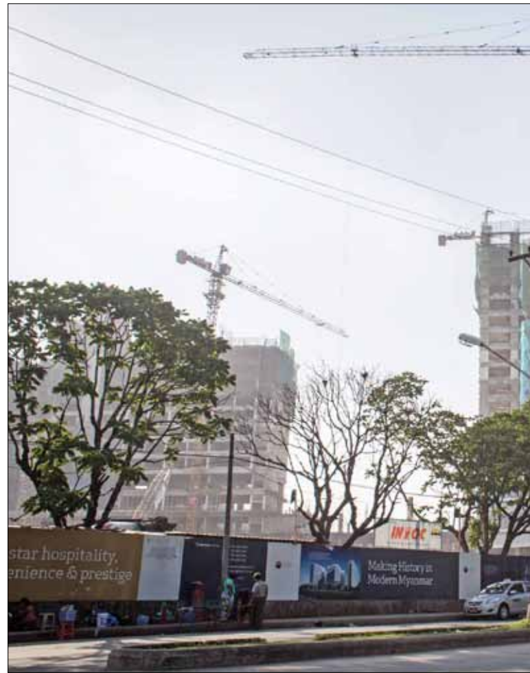
ရန်ကုန်မြို့ ကမ္ဘာအေးဘုရားလမ်းမပေါ်တွင် တည်ဆောက်လျက်ရှိသော ဗီယက်နမ်ကုမ္ပဏီက ဆောက်လုပ်ရေးလုပ်ငန်းခွင်ကို တွေ့ရစဉ်။ ဓာတ်ပုံ-ဇာနည်မြိုး
