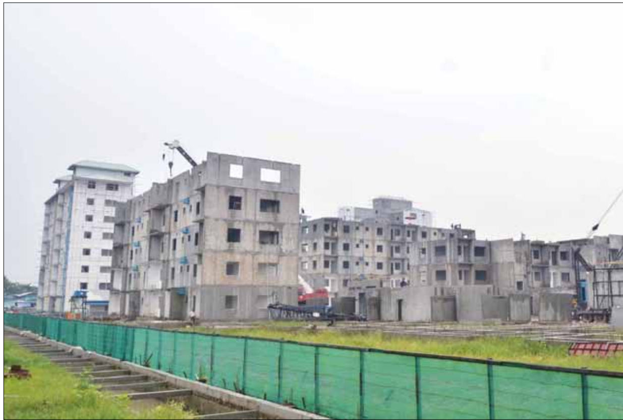
ဒဂုံမြို့သစ်(မြောက်ပိုင်း)မြို့နယ်၊ ဗိုလ်မှူးဗဟိုလမ်းမပေါ်တွင်တည်ရှိသော ဆောက်လုပ်ဆဲ ဗိုလ်ဗဟို တန်ဖိုးမျှတအိမ်ရာကို ယခုနှစ်ရှည်လကုန်
