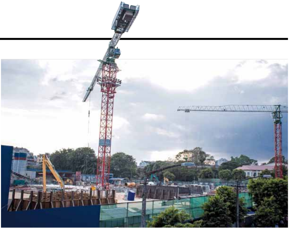
ယခင် ဗိုလ်ချုပ်ဈေးသစ်နေရာတွင် တည်ဆောက်လျက်ရှိသော Junction City Project တွင် စင်ကာပူအခြေစိုက် Keppel Land ကုမ္ပဏီက ဝင်ရောက်ရင်းနှီးမြှုပ်နှံသွားမည် ဖြစ်သည်။ ဓာတ်ပုံ-ဇာနည်ဖြိုး
