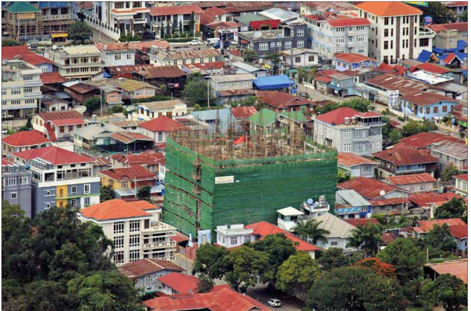
တောင်ကြီးမြို့၏ ပထမဆုံး အဆင့်မြင့် ကွန်ဒိုအဆောက်အအုံ၏ ဆောက်လုပ်ရေးလုပ်ငန်းခွင်ကို တွေ့ရစဉ်။ ဓာတ်ပုံ-နန်းထိုက်ရွှေစင် ဆောက်လုပ်ရေး
