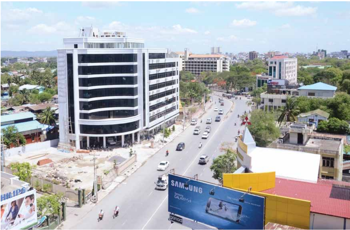
အစိမ်းရောင်မြို့တော်အဖြစ် တည်ဆောက်မည့် မန္တလေးမြို့တစ်နေရာကို တွေ့ရစဉ်။ ဓါတ်ပုံ - စည်သူလွင်
