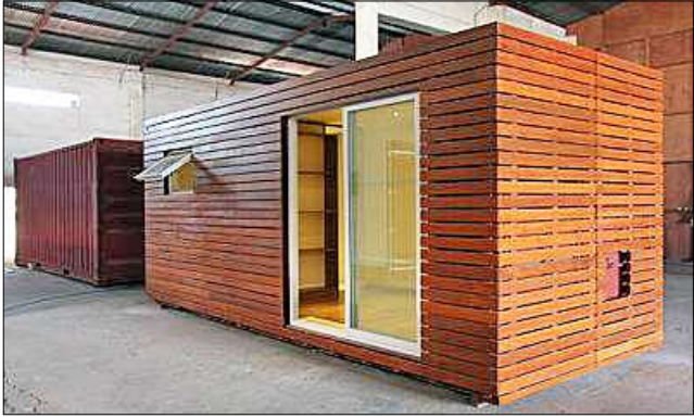
အရည်အသွေးပြည့်ကွန်တိန်နာများကို အသုံးပြု၍ ဆောက်လုပ်ထားသော mobile house များကို တွေ့ရစဉ်။ ဓာတ်ပုံ - supplied
