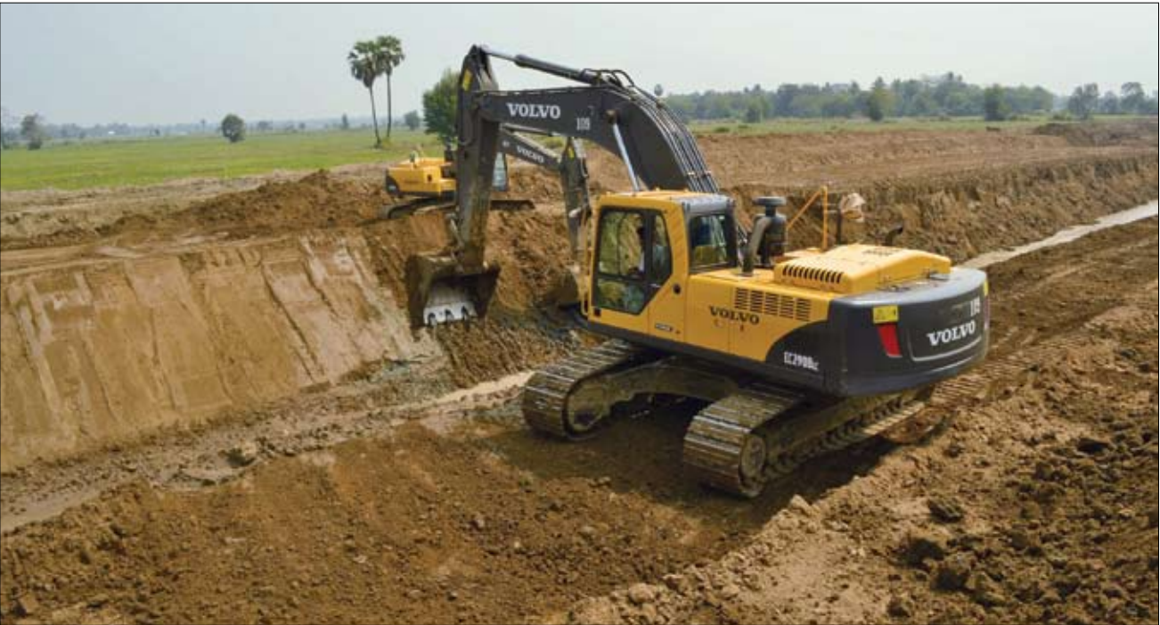
လယ်မြေများအတွင်း ဖြတ်သန်းကာ ဆည်မြောင်းစီမံကိန်းတည်ဆောက်နေသည်ကို ဖေဖော်ဝါရီလလယ်က တွေ့ရစဉ်။ ဓာတ်ပုံ-ထူးအောင်
