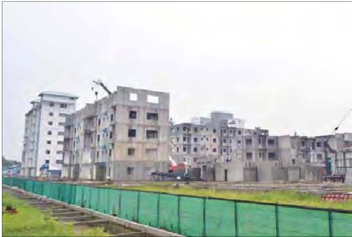
ဒဂုံမြို့သစ်(မြောက်ပိုင်း)မြို့နယ်၊ ဗိုလ်မှူးဗထူးလမ်းမပေါ်တွင်တည်ရှိသော ဆောက်လုပ်ဆဲ ဗိုလ်ဗထူး တန်ဖိုးမျှတအိမ်ရာကို ယခုနှစ်ရှည်လကုန်
