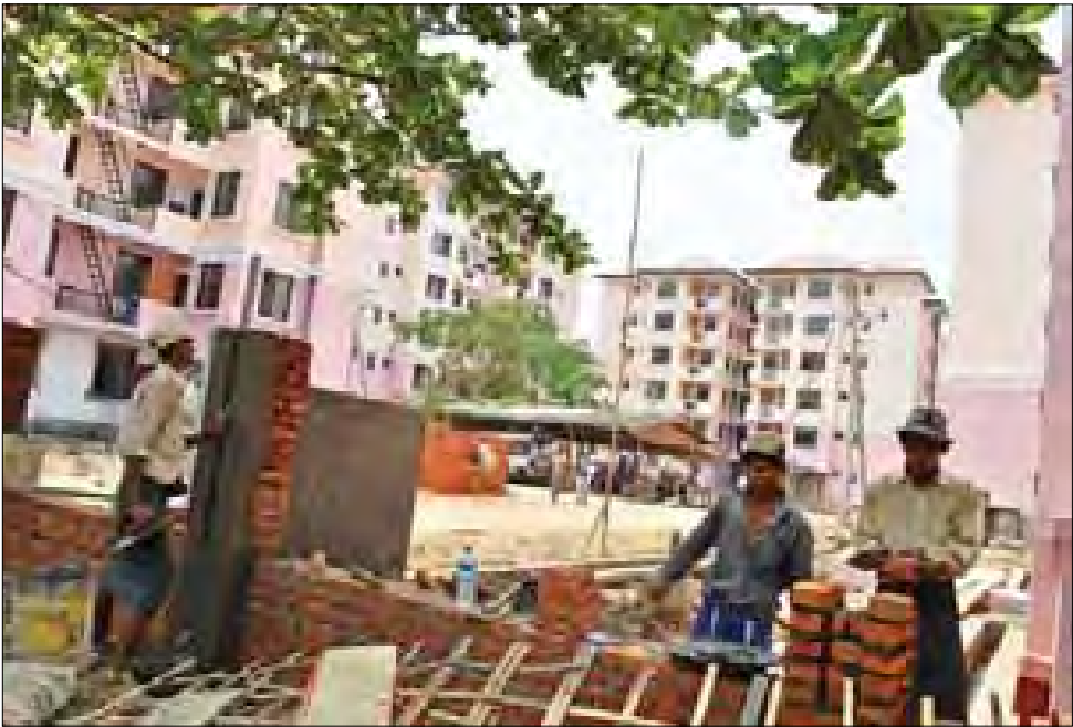
ရန်ကင်းမြို့နယ်၊ (၅)ရပ်ကွက်ရှိ တည်ဆောက်ပြီးစီးသည့် တိုက်သစ်များကို တွေ့ရစဉ်။ အဆိုပါတိုက်သစ်များကို ရန်ရှင်းလမ်းမပေါ်ရှိ အစိုးရတိုက်ဟောင်းများတွင် နေထိုင်သူများ ဩဂုတ် ၇ ရက်တွင် တရားဝင်စတင်နေထိုင်မည်ဟု သိရသည်။ ဓာတ်ပုံ - အောင်ဌေးလှိုင်
