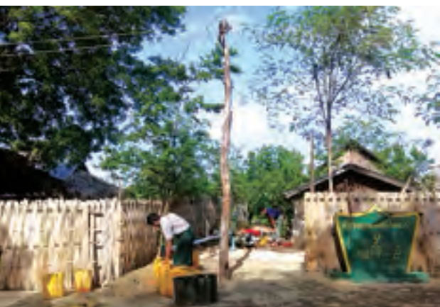
ကျောက်ပန်းတောင်းမြို့နယ် ပုပ္ပားမြို့ရှိ စတ္တိန်းစံပြကျေးရွာတွင် နေရောင်ခြည်စွမ်းအင်သုံး ဆိုလာစနစ်ဖြင့် ကျေးရွာမီးလင်းရေးဆောင်ရွက်ထားမှုကိုတွေ့ရစဉ်။
