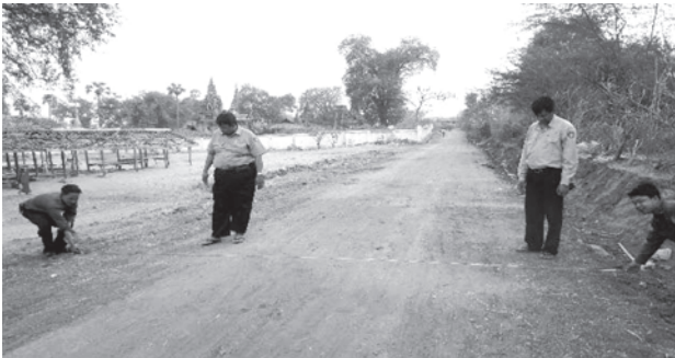
မတ် ၁၄ ရက်က မိတ္ထီလာမြို့နယ်၊ စည်ပင်သာယာရေးအဖွဲ့၏ ၂၀၁၂-၂၀၁၃ ဘဏ္ဍာရေးနှစ် မှန်တိုင်ရွာတွင်း ကျေးလက်လမ်းကျောက်ချောခင်းခြင်းလုပ်ငန်း ဆောင်ရွက်နေမှုကို အမှုဆောင်အရာရှိ ဦးသန့်ဇင်နှင့် အင်ဂျင်နီယာမှူး ဦးအောင်နိုင်ဦးတို့ ကြီးကြပ်ဆောင်ရွက်စဉ်။ (မြို့နယ်စည်ပင်)
