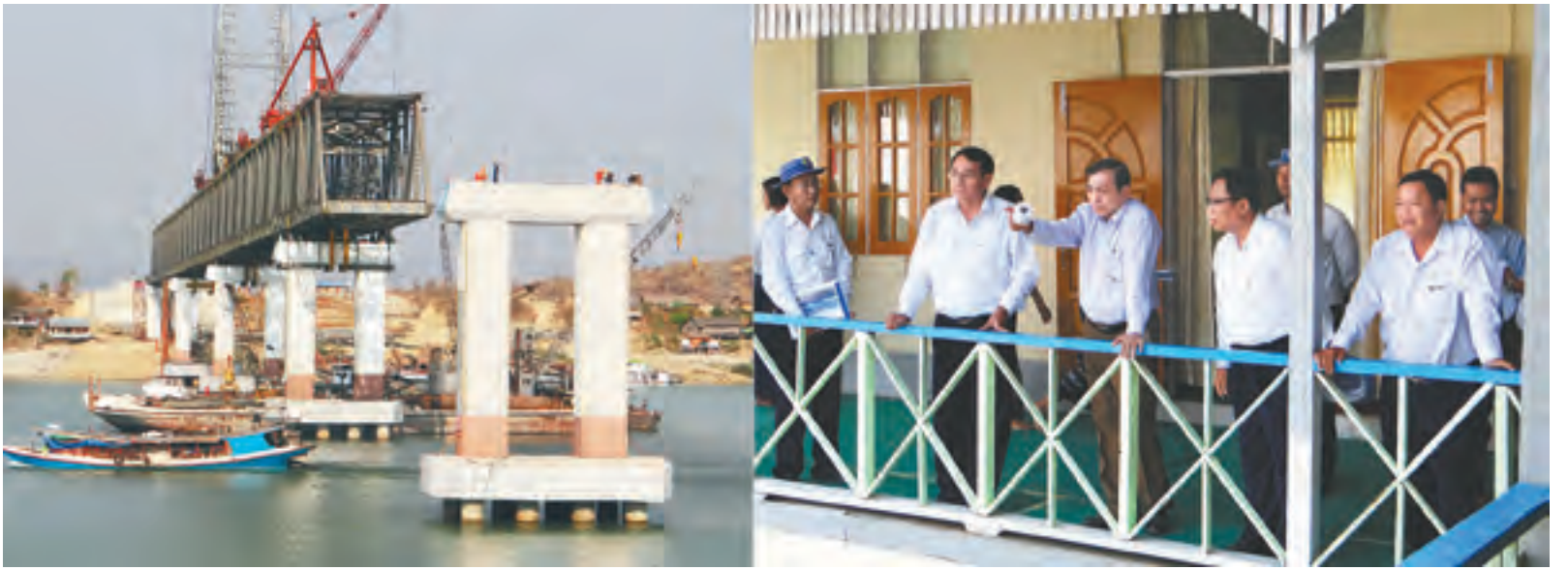
ပြည်ထောင်စုဝန်ကြီး ဦးကျော်လွင် ဧရာဝတီတံတား(ရတနာသီယံ)တည်ဆောက်ရေးလုပ်ငန်းခွင်၌ တံတားသံပေါင်များ တပ်ဆင်နေမှုကို ကြည့်ရှုစစ်ဆေးစဉ်။
