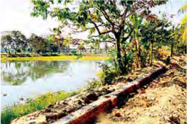
ထို့အပြင် အလတ်ချောင်းရပ်ကွက်ရှိ ပေ ၁၆၃၀ ကျယ်ဝန်းသော အောင်မင်္ဂလာ နှစ်ကန်တွင် ခြံစည်းရိုးပတ်လည်အုတ်ရိုးများစီခြင်းကို စတင်ဆောင်ရွက်နေပြီဖြစ်သည်။
