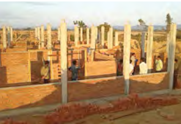
ကလေးမြို့နယ် လျှပ်စစ်အင်ဂျင်နီယာရုံး၌ Control Building တည်ဆောက်နေစဉ်။
