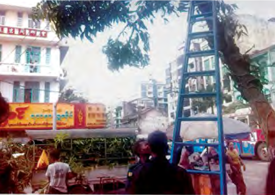
လသာမြို့နယ် လမ်းမတော်လမ်းနှင့်မဟာပန္နလမ်းထောင့်ရှိ လျှပ်စစ်ဓာတ်အား လိုင်းကြိုးများနှင့်မလွတ်ကင်းသောသစ်ကိုင်းများကို မြို့နယ်လျှပ်စစ်ဝန်ထမ်းများဆုတ်ထွင်ရှင်းလင်းပြီး ယာဉ်ငယ်ဖြင့် သယ်ယူရှင်းလင်းနေသည်ကို ဇန်နဝါရီ ၁၈ ရက် နေ့လယ်က မြင်တွေ့ရပုံ။
