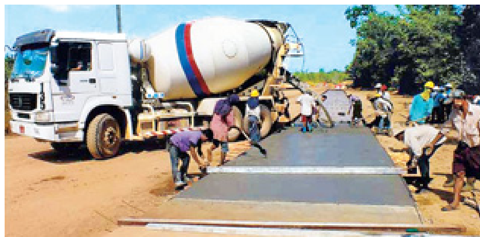
မကျီးကန်-ငှက်အော်စမ်း-ကျိုက်ထော်ကျေးလက်လမ်းကို အဆင့်မြှင့်တင်၍ ကွန်ကရစ်ခင်းနေ့စဉ်။
